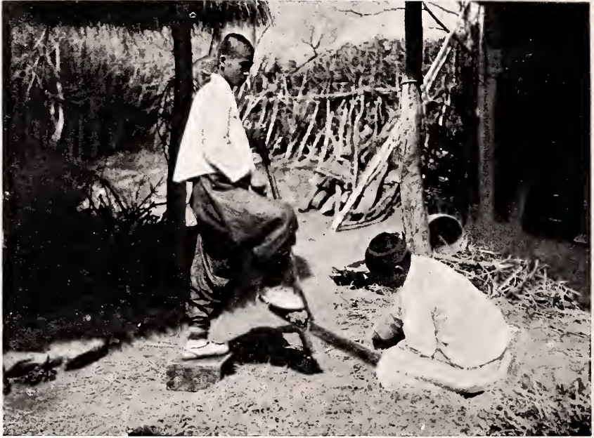
Häckselschneiden. Vermischt mit feingesiebtm Kalk und gekochtem Papier dient das Häcksel zum Glattstrich der Innenwände
